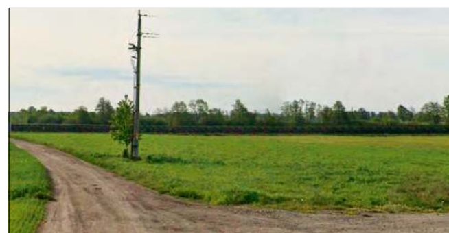
Farma fotowoltaiczna znajduje się przy ulicy Ogrodowej w Chrzastowicach. Są plany, żeby ją rozbudować i wybudować tam magazyn energii.
