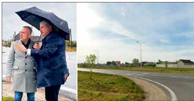
Skrzyżowanie ulicy Kotorskiej z DK 46 jest bardzo niebezpieczne i nie ma w jego pobliżu przejścia dla pieszych. A tamtędy chodzą dzieci do szkoły...
