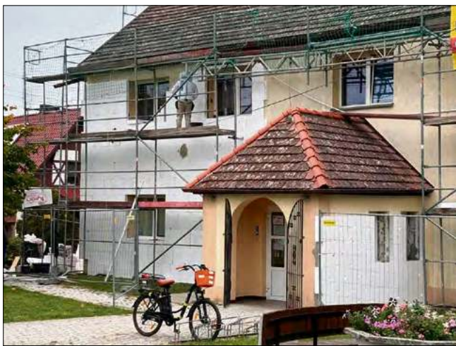
Termomodernizacja budynku OPS w Dąbrowie.
