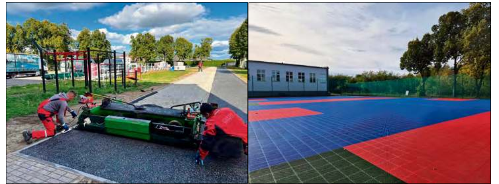
Przebudowa boiska szkolnego wraz z budową bieżni przy PSP Dąbrowa.
