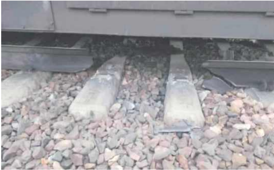
W niedzielę (16 listopada) rano w rejonie miejscowości Życzyn w powiecie garwolińskim maszynista zauważył, że uszkodzony został fragment torowiska
