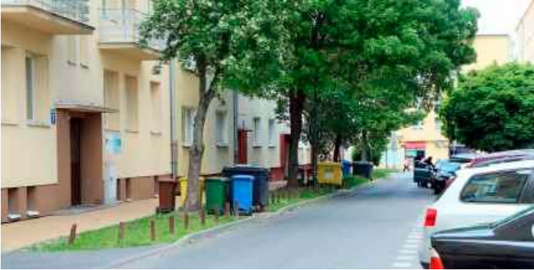
Jeden z ogrodów deszczowych powstanie przy ul. Ochotniczej
