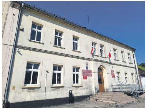
Budynek urzędu przechodzi termomodernizację
