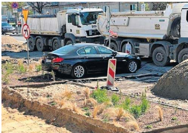
Dwa samochody utknęły na remontowanej ulicy Zaolziańskiej w Łodzi
