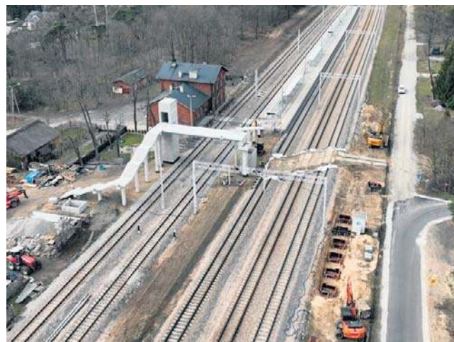
Gotowa jest pierwsza część przeprawy złożonej z dwóch podpór i pomostu nad dwoma torami.
