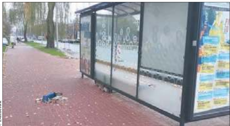
Nowa wiata przystankowa i wystający na środku chodnika kabel
