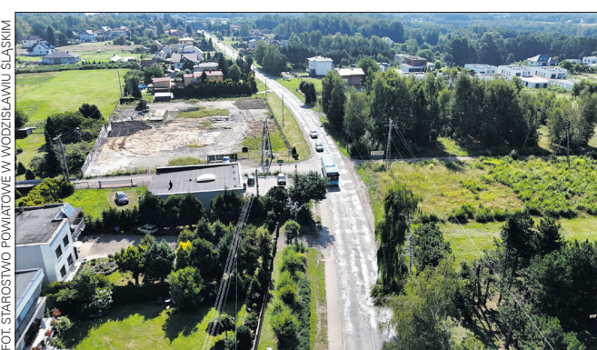
Wykonawca został wybrany, a umowa podpisana. Przed mieszkańcami Turzy Śląskiej, Wodzisławia Śląskiego i Krostoszowic 20 miesięcy dużych robót drogowych.
