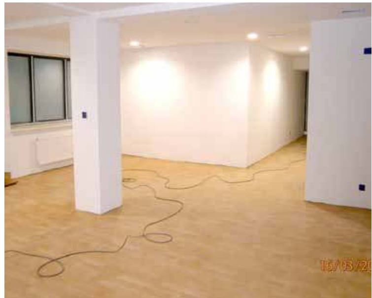
W środku AquaStar montowane jest oświetlenie, głośniki, kamery.
