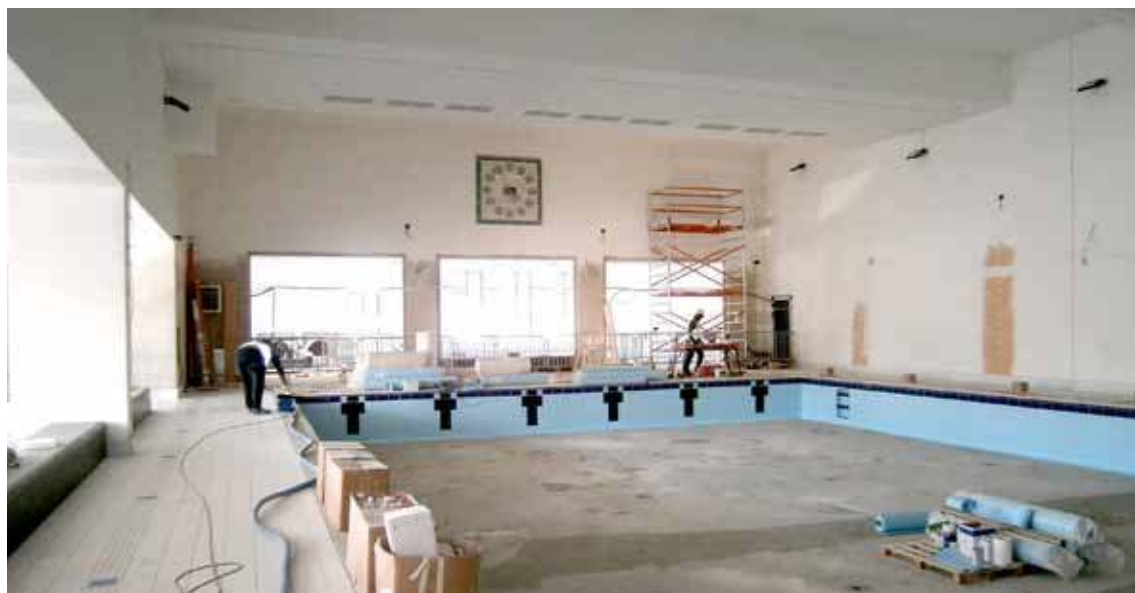
Trwają również prace na basenie.
