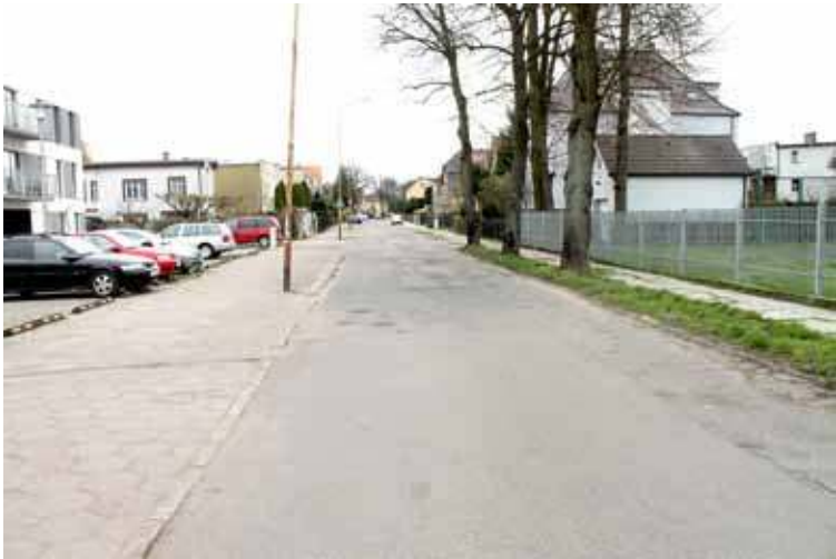
Nawierzchnia na ul. Andersa zostanie odnowiona
