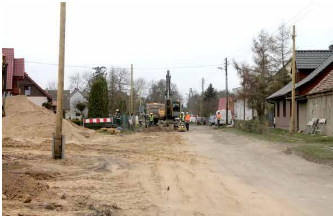
Na taki widok remontowanej drogi mieszkańcy Kunowa czekali od lat
