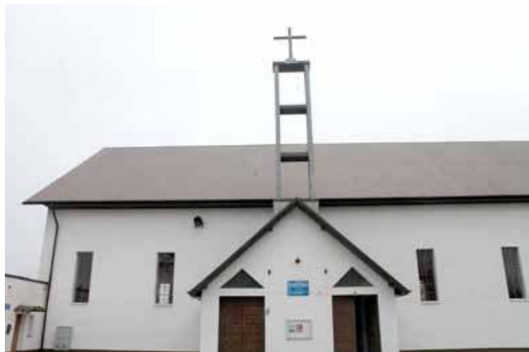
Dzwon zostanie zainstalowany na metalowej wieżycze kościoła, jako dar wdzięczności ks. proboszcza i wiernych za 25 lat istnienia parafii
