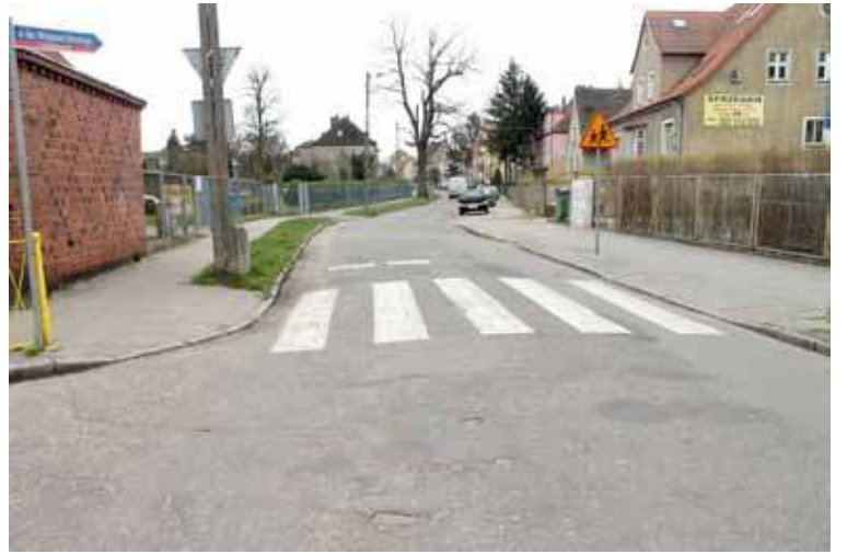
A na ulicy Sikorskiego mają wreszcie zniknąć wyboje i dziury
