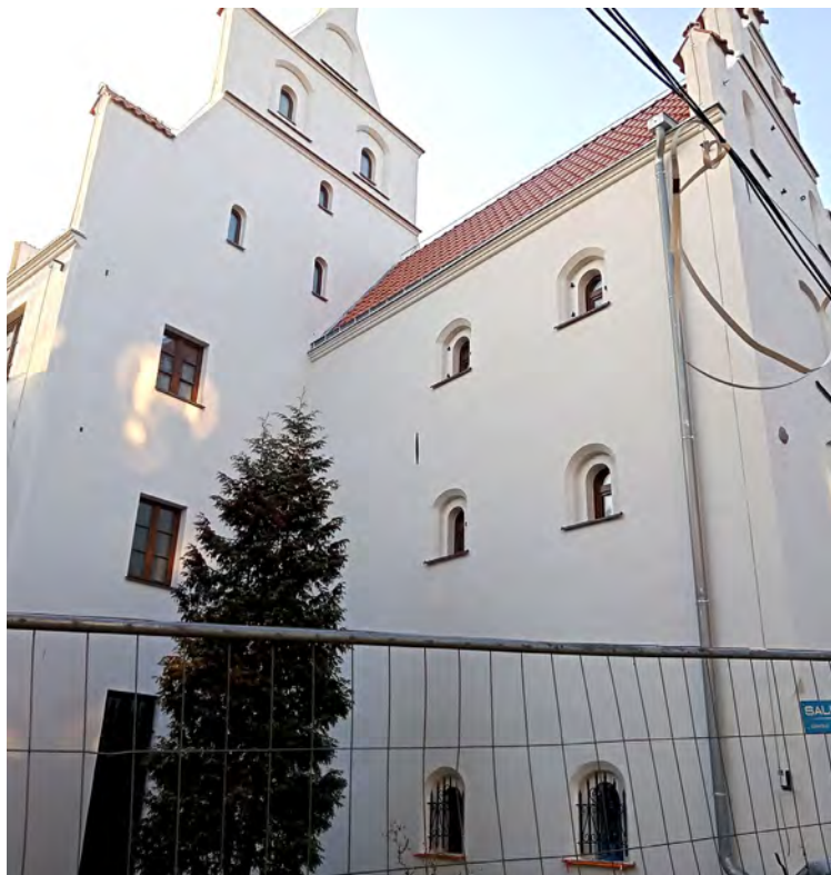
Odnawiana jest również elewacja budynku
