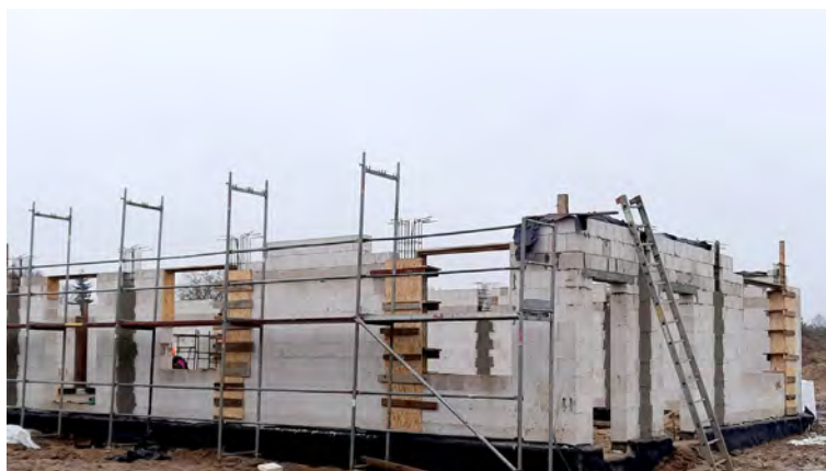
Trwają prace związane z budową przedszkola, w którym docelowo znajdzie się 100 miejsc dla dzieci
