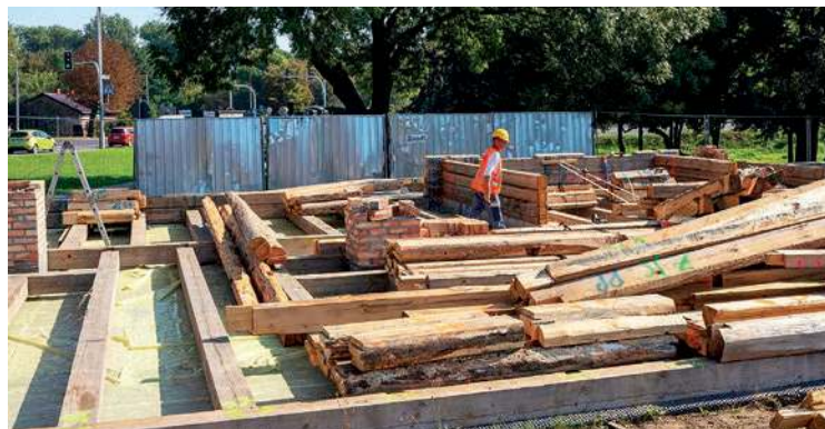
Prace związane z odbudową budynku Kolei mają skończyć się w przyszłym roku
