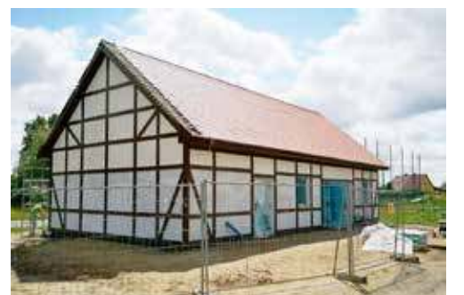
Budowa świetlicy w Maszkowie, gotowa ma być jesienią i to nawet wczesną
