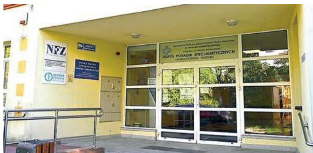
Budynek, w którym mieszczą się specjalistyczne poradnie, zostanie wyremontowany
