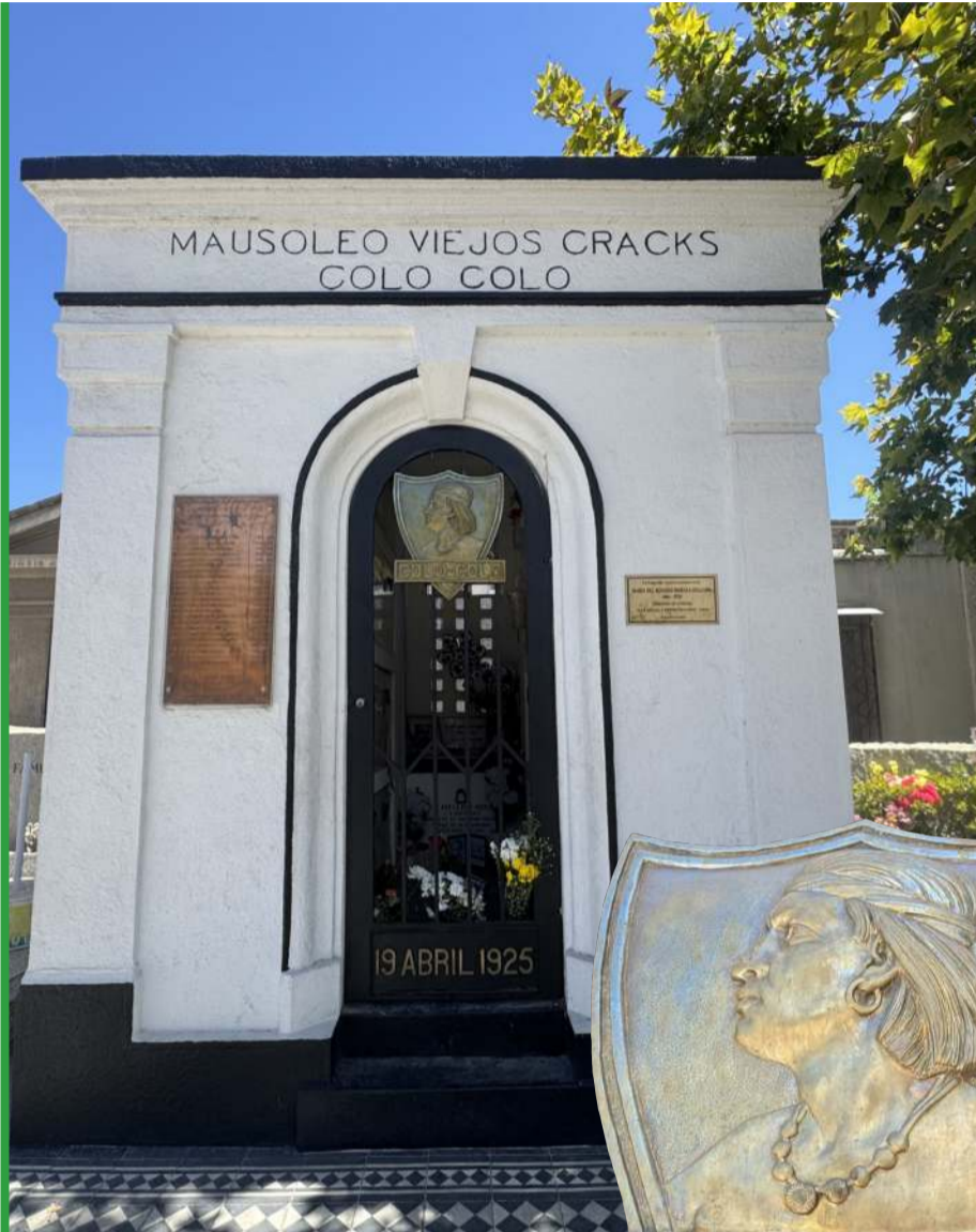
Mausoleo de los Viejos Cracks Colo-Colo.
