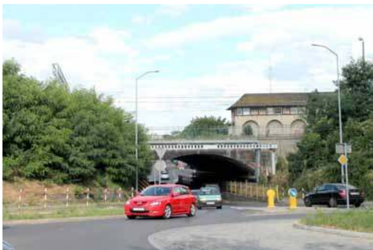
Gdy na początku września zostanie ponownie otwarty wiadukt na 1 Brygady, to wtedy prace przeniosą się na wiadukt na Ks. Bogusława IV, gdzie również zostanie przełożona sieć ciepłownicza
