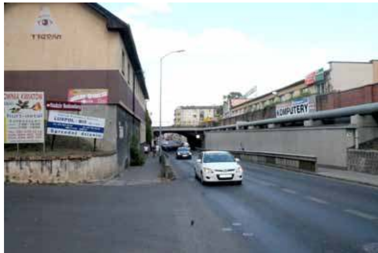
W związku z pracami na wiadukcie przy ul. 1 Brygady polegających na przełożeniu instalacji ciepłowniczej, od 2 sierpnia wiadukt ten zostanie zamknięty na 1 miesiąc.
