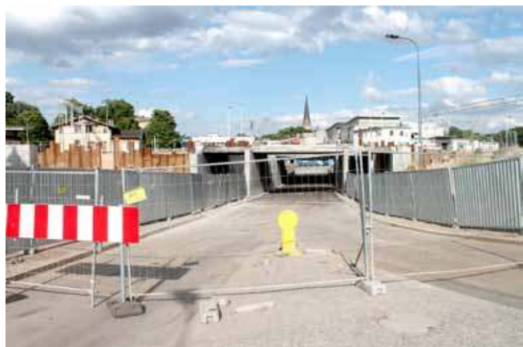
W październiku konieczne będzie jeszcze tymczasowe zamknięcie ruchu pod wiaduktem przy ul. Wyszyńskiego ze względu na prace m.in. przy ścianach oporowych. Prace potrwać do listopada
