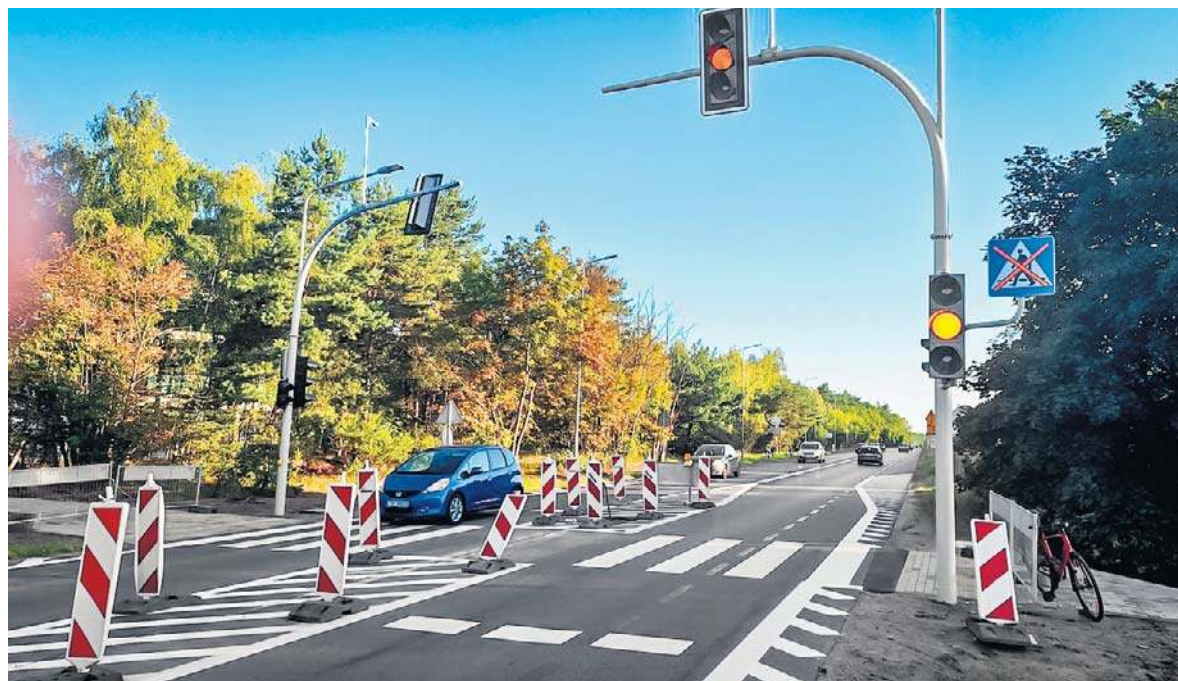
Budowa przejścia dla pieszych na wysokości przystanku Toruń Katarzynka jest na ukończeniu
