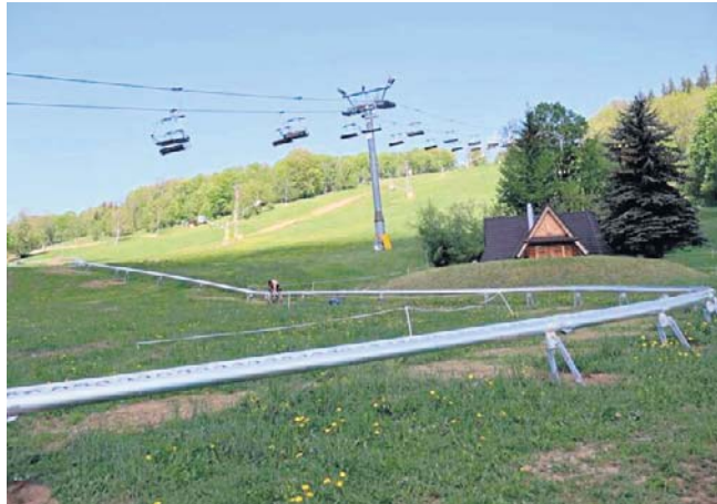
Budowa zjeżdżalni grawitacyjnej na stacji narciarskiej na Harendzie w Zakopanem
