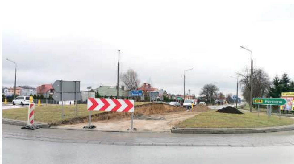
Rondo na ul. Wisznickiej wygląda inaczej niż zazwyczaj. Kilka dni usuwano z nasypu ziemię. Jak się okazuje, będą drogą krajową przewożone ponadnormatywne elementy
