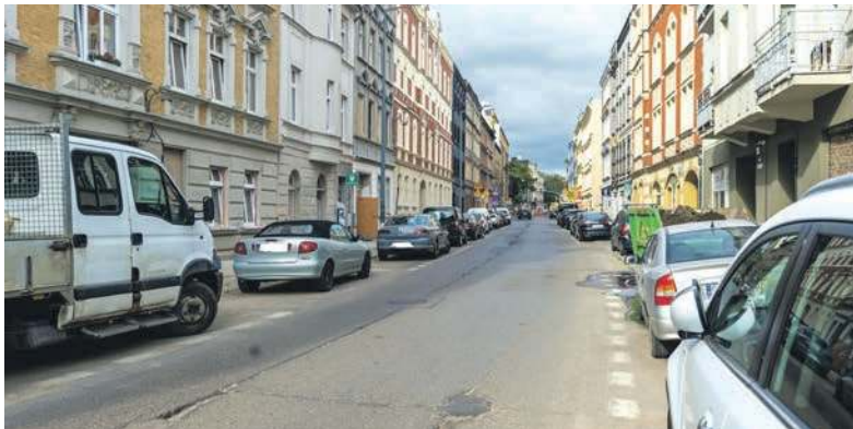
Kamienice przy Piłsudskiego pięknieją jedna za drugą. teraz czas na remont samej jezdni
