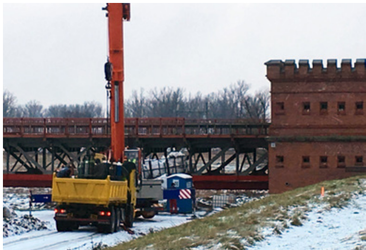
Koszt realizacji całego zadania w Ścinawie to ponad 27,9 mln zł. Wykonawcą jest firma Berger Bau Polska. Roboty mają potrwać do listopada 2021 r.
