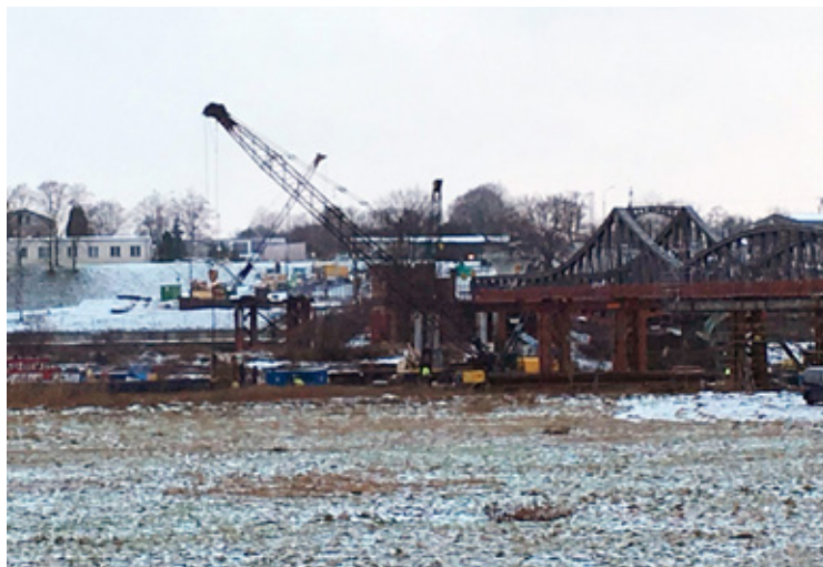
Przeprawa tymczasowa w Ścinawie do użytku oddana ma zostać w II kwartale 2021 r. Wtedy też będą mogły rozpocząć się główne roboty w ramach modernizacji ponad 100-letniego mostu
