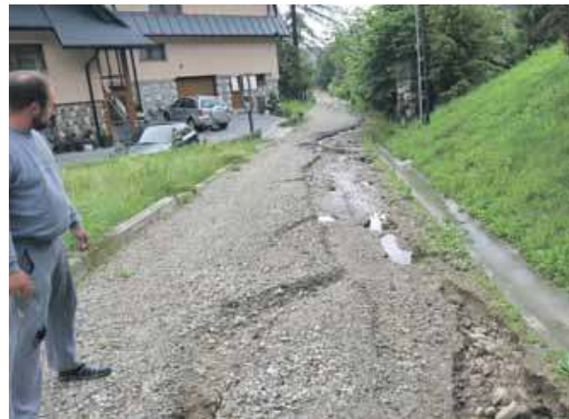
Tyle zostało po zeszłorocznym remoncie przy ul. Tatrzańskiej.
