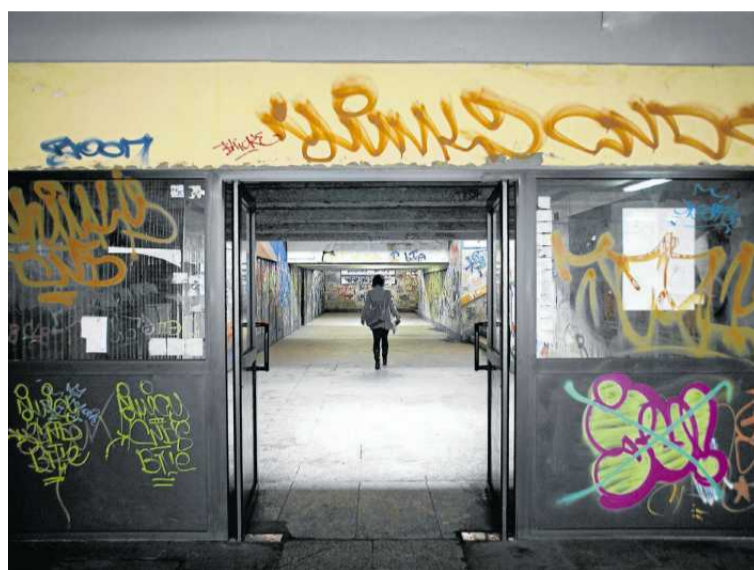
◀ Zniszczony dworzec kolejowy w Katowicach-Ligocie w 2010 r. FOT. MARTA BŁAŻEJOWSKA / AGENCJA WYBORCZA.PL
