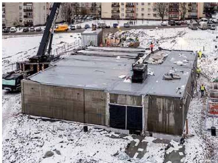
Nowe miejskie przedszkole powstaje przy zastosowaniu nowoczesnej technologii modułowej
