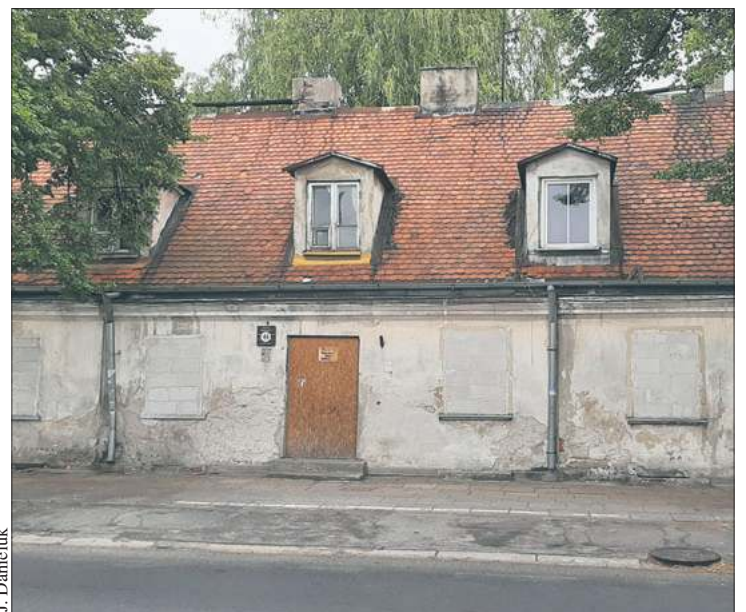
Przy ul. Sienkiewicza 44 stanie nowy budynek
