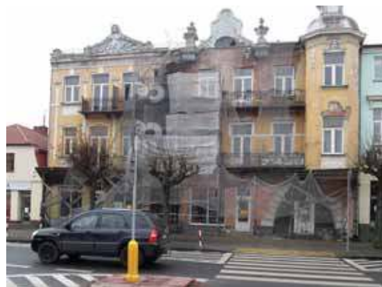
Obiekt wymaga szybkiego remontu
