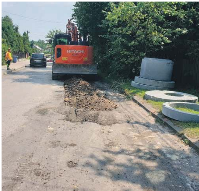
Roboty kanalizacyjne na Żbickiej w Krzeszowicach
