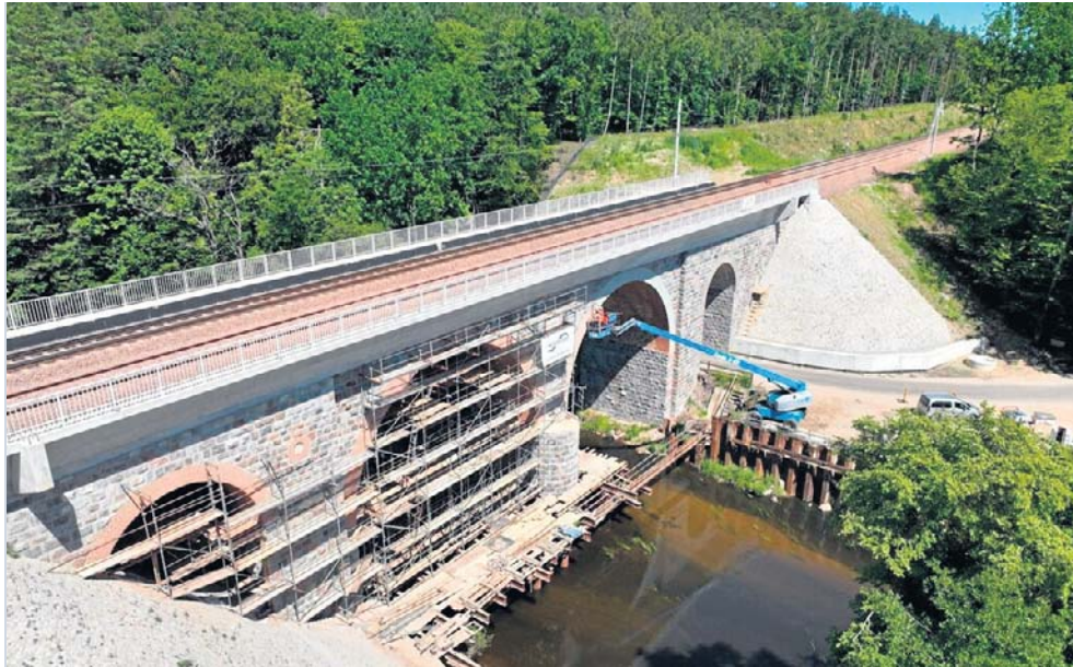
Remontowany most kolejowy nad rzeką Łupawą w Łebieniu
