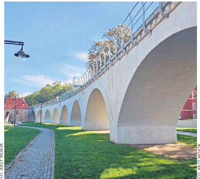
Efektowna estakada to architektoniczna perełka pochodząca z 1911 roku
