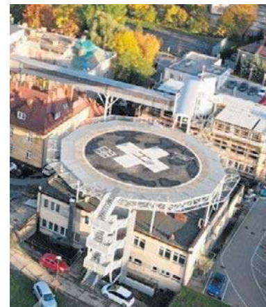
Lądowisko dla helikopterów przy szpitalu w Bochni
