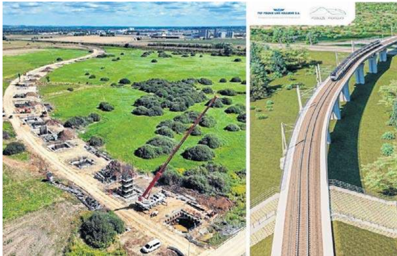
Tak powstaje nowa estakada kolejowa pod Krakowem
