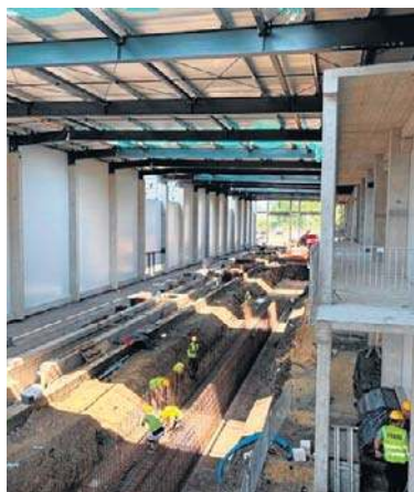
Budowa centrum serwisowego, postępuje bardzo szybko
