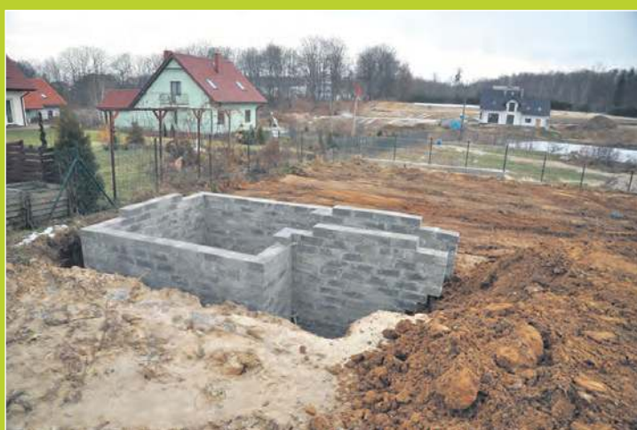
Ziemianka została wybudowana na głębokości 1,5 metra.
