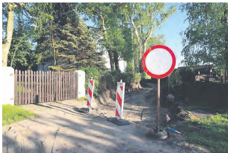
Plac budowy. Ulica Pocztovej w Pruszczu.
