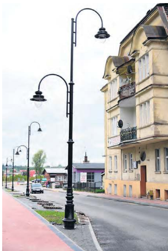
Ulica Chopina czeka już tylko na ostatnią warstwę nawierzchni.
