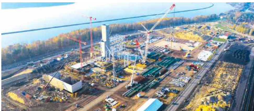
Nowo budowany blok gazowo-parowy w Rybniku
