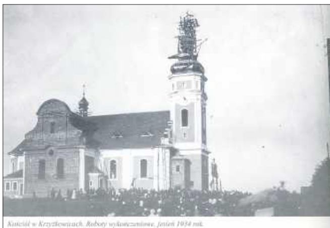
■ Jedno z nielicznych zachowanych zdjęć budowy kościoła w Krzyżkowicach
