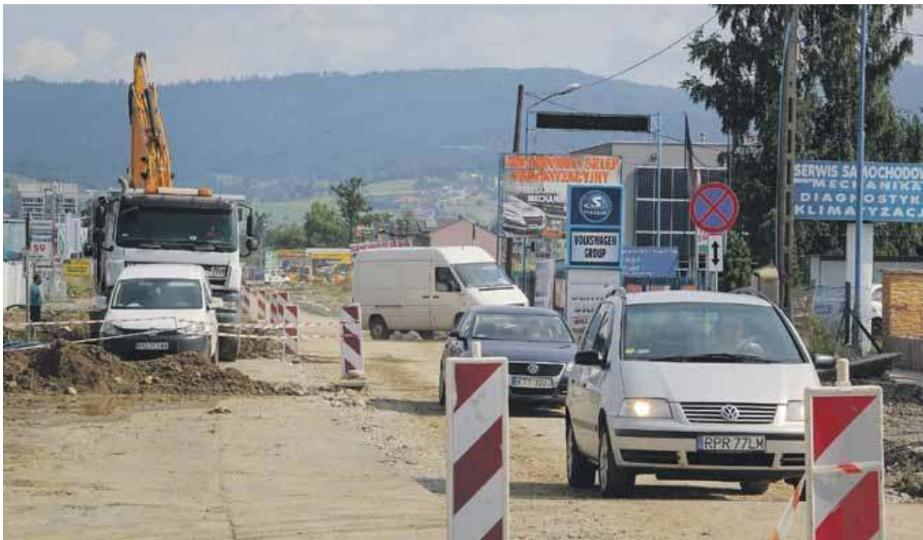
Ul. Szaflarska to plac budowy dostępny dla ruchu.
