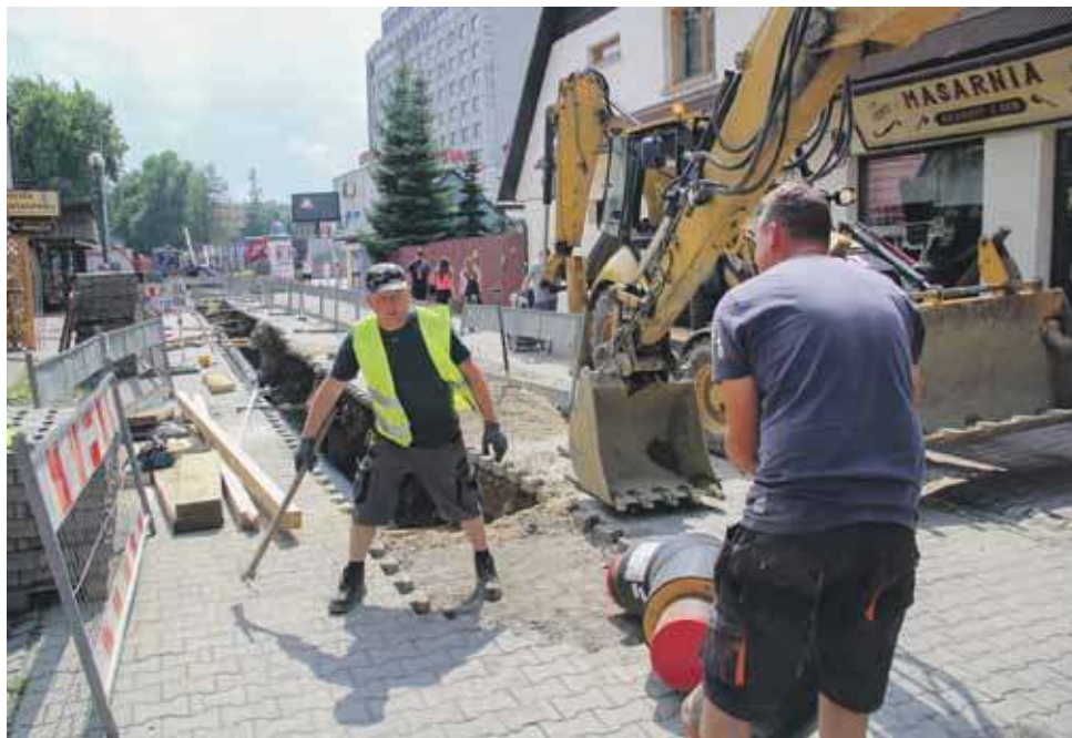
Trwa układanie rur ciepłowniczych w ul. Krzywej.
