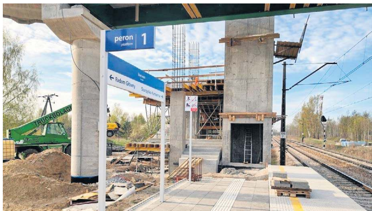
Postępują prace przy budowie kładki dla pieszych i przystanku kolejowego Radom Południowy.
