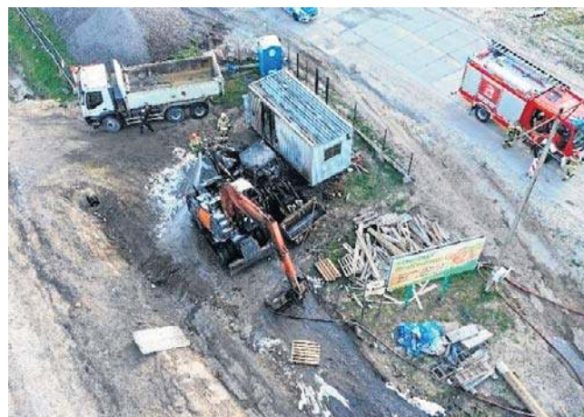
Pożar na placu budowy przy ulicy Puławskiej w Warce. Ogień zniszczył dwie koparki oraz budynek socjalno-magazynowy, na miejscu działało kilka zastępów straży pożarnej.
