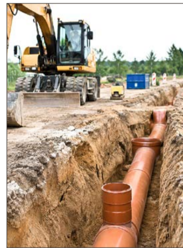
Budowa kanalizacji w gminie to jedno z priorytetowych zadań.
