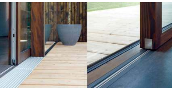
🔧 Okna tarasowe dobrze jest wyposażać w niski próg lub zlicowany z podłogą. SIEGENTIA
