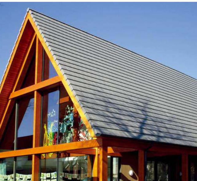
🔴 Pokrycia mniej szczelne, np. dachówki, zaleca się układać na dachach o większym spadku. WIENERBERGER
