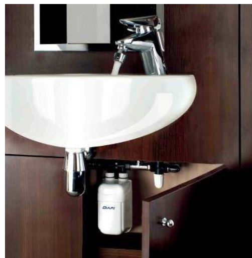
➤ Podgrzewacz przepływowy jest niewielki, ale musi mieć dużą moc. DAFI (FORMMASTER)
