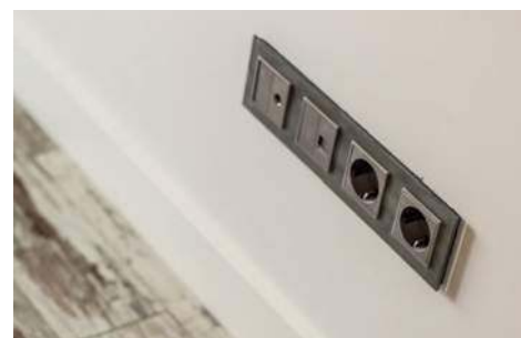
🔌 Obecnie najchętniej stosuje się tzw. osprzęt modułowy, gdyż pozwala to zgrupować kilka gniazd we wspólnej ramce, nawet jeżeli mają one zupełnie inne przeznaczenie. LIVULO
