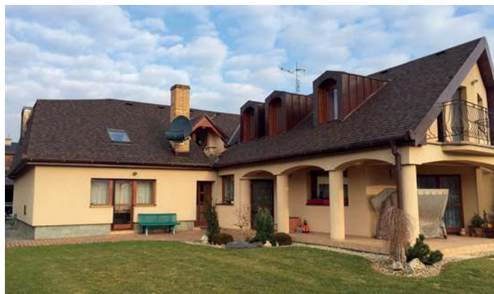
🔹 Gont bitumiczny układa się na pełnym deskowaniu. IKO
