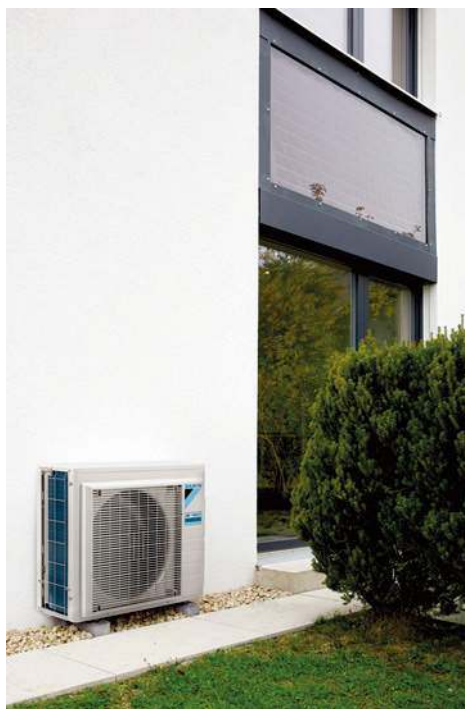
Jednostka zewnętrzna klimatyzatora typu multi split. DAIKIN
