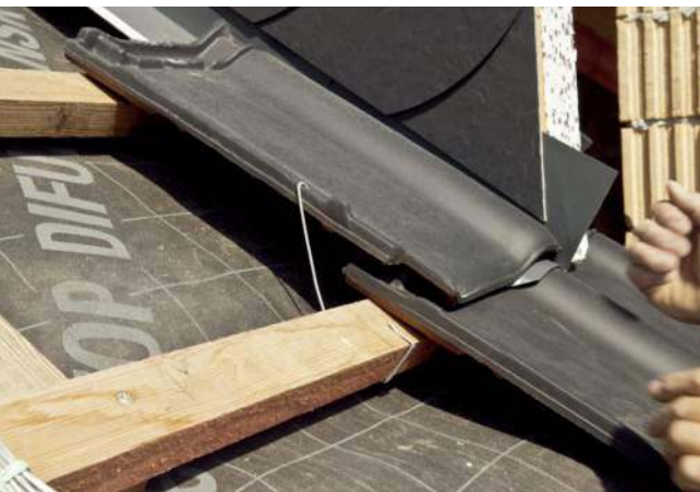
🔴 Dachówka układana na ruszcie z łąt i kontrłąt. RÖBEN
