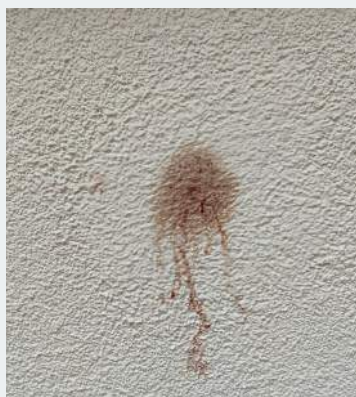
Po pierwszym deszczu, na tynku pojawiły się liczne plamy.
