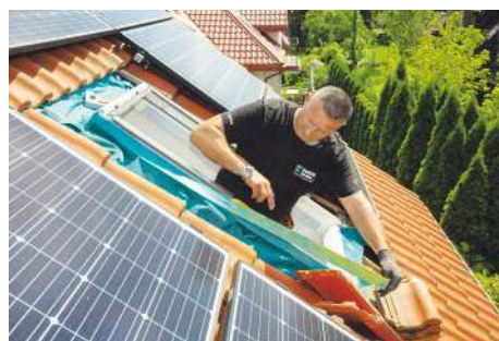
Wymiana okien w dachu jest prosta, bo kupuje się je z zestawem montażowym zawierającym kołnierz uszczelniający, dopasowany do kąta nachylenia połaci i rodzaju pokrycia. FAKRO
