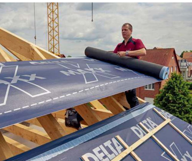
🔴 Za szczelność dachu odpowiada nie tylko pokrycie, ale i znajdujący się pod nim podkład. DÖRKEN
