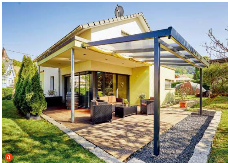
(a) Zadaszenie z poliwęglanu na konstrukcji aluminiowej z dwoma (a) i trzema (b) pionowymi podporami (słupami). GUTTA
