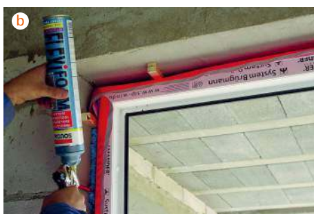
Pierwszym etapem wymiany stolarki jest wykonanie dokładnych pomiarów otworu okiennego (a) MS WIĘCEJ NIŻ OKNA ). Okna mocuje się do ścian i przestrzeni między ramą a ścianą wypełnia pianką montażową (b) Soudal , którą zabezpiecza się od zewnątrz taśmą paroprzepuszczalną, a od wewnątrz – paroszczelną (c) Soudal .
