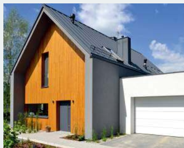
📌 Na fasadzie frontowej – okładzina z modrzewia syberyjskiego, zaimpregnowana i zabezpieczona lazurą.
