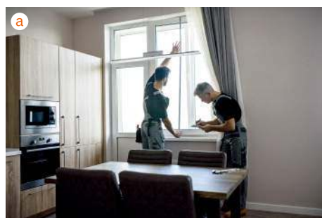
Pierwszym etapem wymiany stolarki jest wykonanie dokładnych pomiarów otworu okiennego (a) MS WIĘCEJ NIŻ OKNA ). Okna mocuje się do ścian i przestrzeni między ramą a ścianą wypełnia pianką montażową (b) Soudal , którą zabezpiecza się od zewnątrz taśmą paroprzepuszczalną, a od wewnątrz – paroszczelną (c) Soudal .
