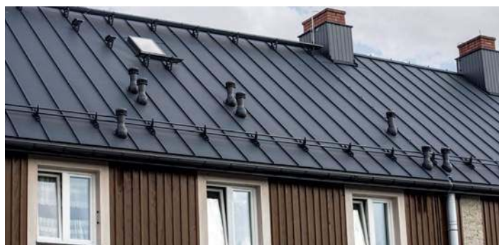
🔹 Płaska blacha panelowa, której połączenie przypomina rzemieślniczy rąbek stojący. BP2
