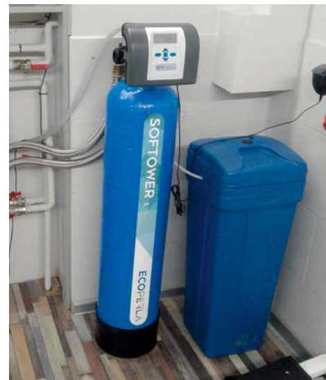
🔧 Zmiękczacze zmniejsza zawartość jonów wapnia i magnezu w wodzie. Montuje się go na końcu instalacji uzdatniania wody. KLARSAN
