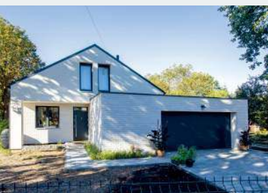
Elewację wykończono tynkiem silikatowym i okładziną betonową, imitującą cegłę.
