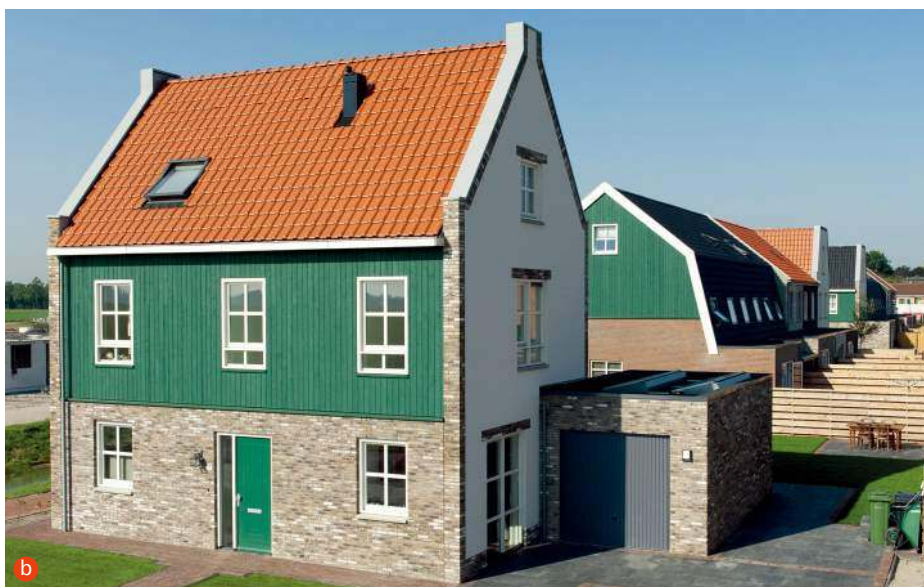
Różny materiał i wykończenie, podobny efekt – dachówka cementowa z błyszczącą powierzchnią (a CREATON POLSKA) i ceramiczna angobowana (b WIENERBERGER).
