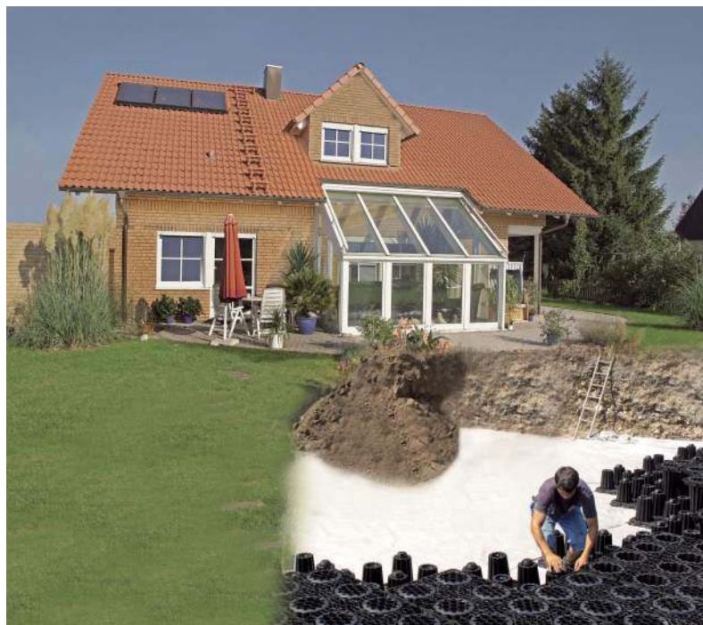
Montaż skrzynek rozsączających. Aco
