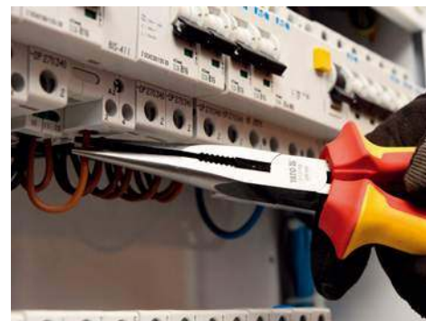
🔌 Obwód to fragment instalacji z odrębnym zabezpieczeniem nadprądowym w rozdzielnicy. YATO (TOYA)
