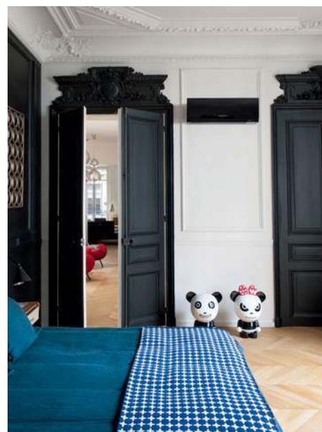
🔥 Jednostkę wewnętrzną montujemy pod sufitem tak, aby nie narazić domowników na bezpośredni nadmuch zimna.
