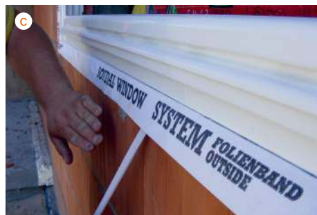
Pierwszym etapem wymiany stolarki jest wykonanie dokładnych pomiarów otworu okiennego (a) MS WIĘCEJ NIŻ OKNA ). Okna mocuje się do ścian i przestrzeni między ramą a ścianą wypełnia pianką montażową (b) Soudal , którą zabezpiecza się od zewnątrz taśmą paroprzepuszczalną, a od wewnątrz – paroszczelną (c) Soudal .
