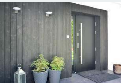
Wnękę przy głównym wejściu obłożono deskami elewacyjnymi z palonego drewna.
