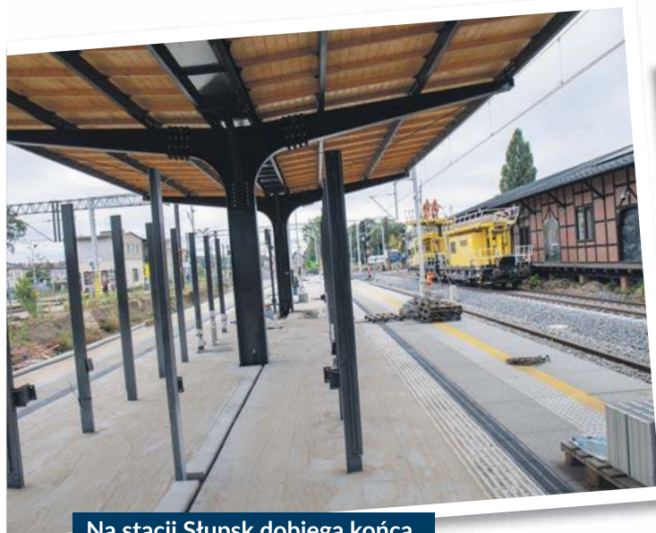
Na stacji Słupsk dobiega końca m.in. przebudowa peronu nr 3
