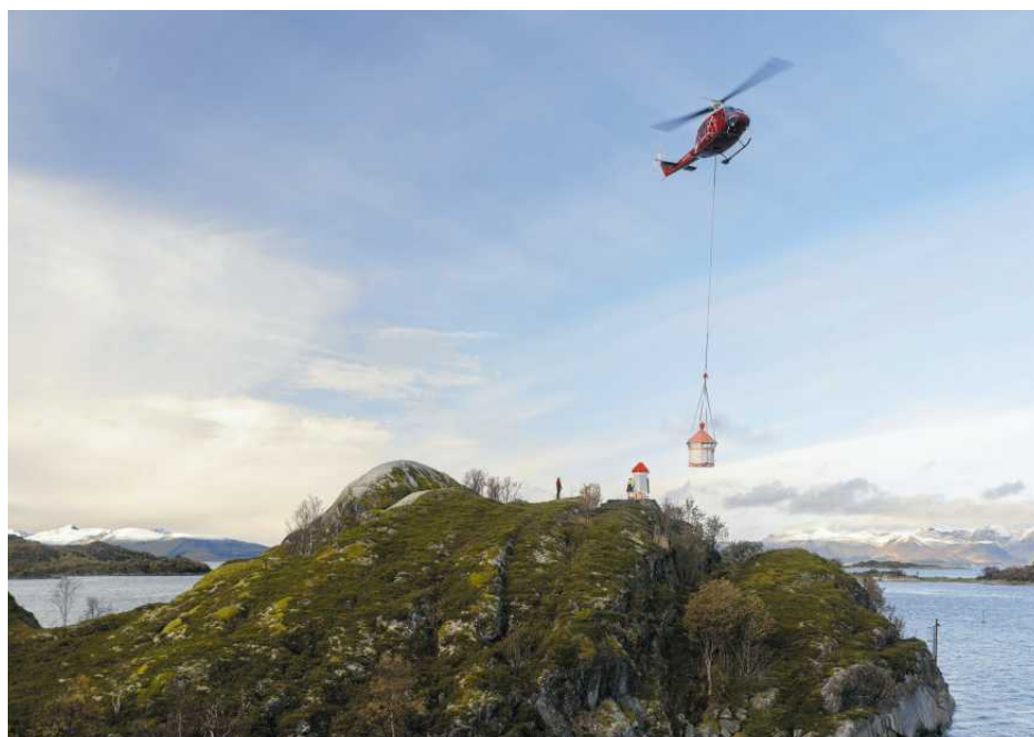
• Mała latarnia morska na wyspie Brattholmen w Norwegii została w lipcu 2024 roku zastąpiona zintegrowaną jednostką wyposażoną w lampę LED, panele słoneczne, baterie i elektronikę do zdalnej obsługi FOT. MICHAŁ SIAREK / THE NEW YORK TIMES
