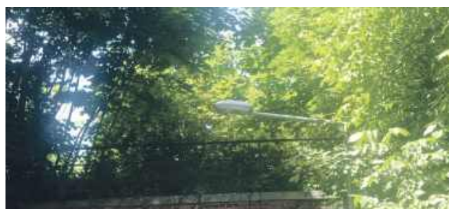
Byłe torowisko na wiadukcie porasta bujna roślinność
