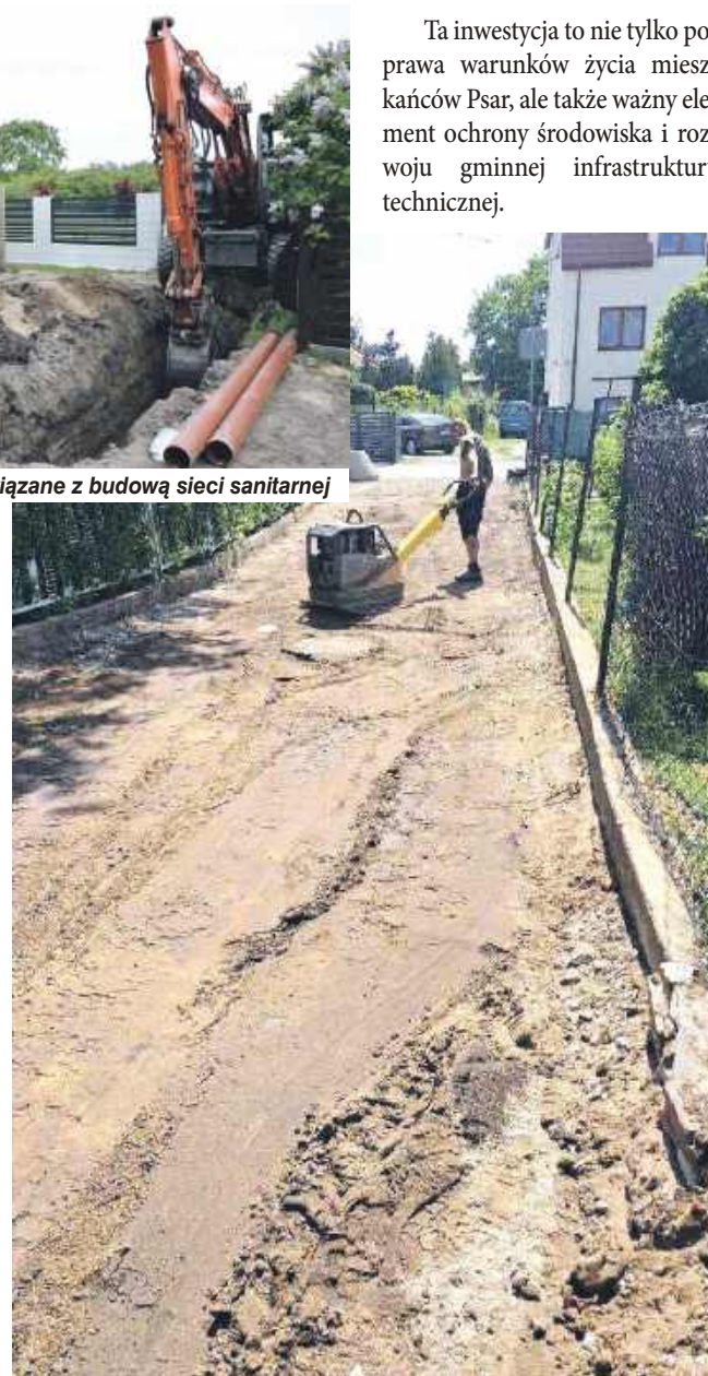
Odtworzenie nawierzchni drogowej po zakończeniu robót
