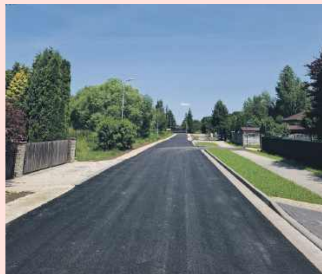
Nowa nawierzchnia ul. Kwiatowej w Szewcach
