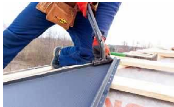
🔧 Układanie paneli na połaci dachu. BLACHY PRUSZYŃSKI
