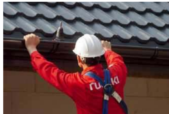
🔧 Montaż orygnowania należy powierzyć dekarzom, którzy mają odpowiedni sprzęt oraz doświadczenie w pracy na wysokości. RUUKKI
