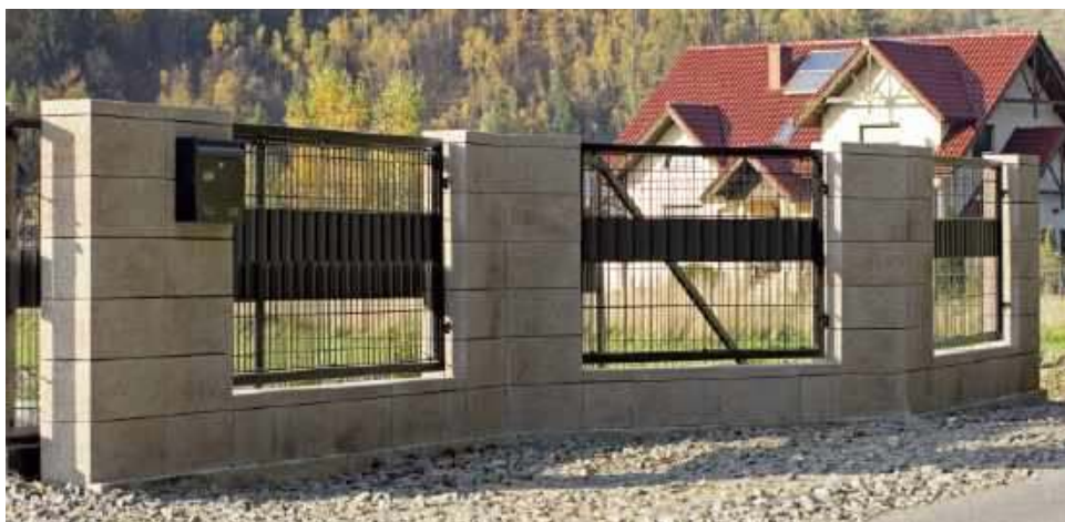
🔗 Panele ze stalowych prętów są trwałe, choć wydają się dość delikatne. Często pomiędzy prętami przeplata się specjalne taśmy, które zmniejszają przezierność ogrodzenia. JONIEC, PLAST-MET SYSTEMY OGRODZENIOWE
