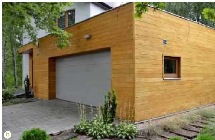
📌 Deski i lamele najczęściej montuje się w pionie (a DLH/YASSEN HRISTOV)) lub w poziomie (b L. JAMPOLSKA).
