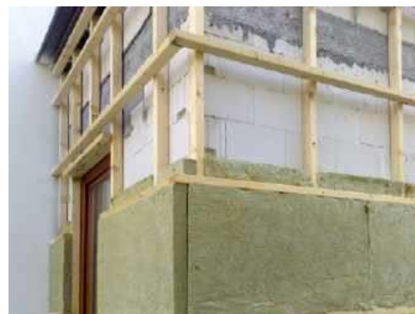
🔦 W metodzie lekkiej suchej ocieplenie podtrzymuje ruszt z drewnianych listew lub metalu. ARCHIWUM BD
