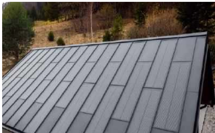
Zintegrowane panele solarne przeznaczone na dachy kryte blachą prawie nie różnią się wizualnie od elementów pokrycia. Taki dach ma jednolitą powierzchnię. BP2
