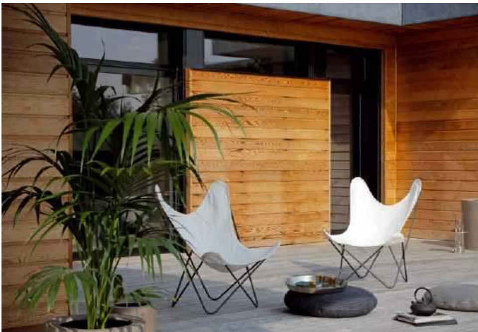
📌 Drewniane elementy elewacyjne zabezpiecza się przed działaniem czynników atmosferycznych preparatami barwiącymi je na przeróżne kolory. v33
