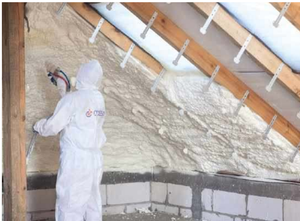
🔥 Coraz popularniejsza jako ocieplenie poddaszy jest piana poliuretanowa PUR наносzona natryskowo. PCC PRODEX
