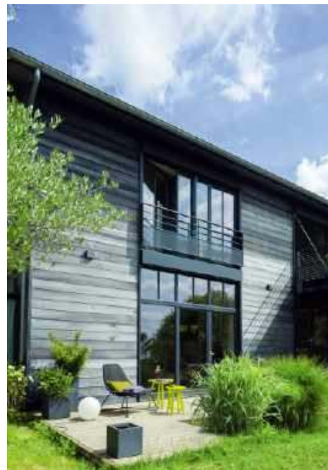
📌 Drewniane elementy elewacyjne zabezpiecza się przed działaniem czynników atmosferycznych preparatami barwiącymi je na przeróżne kolory. v33
