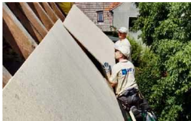
➤ Sztywne poszycie najłatwiej wykonać z drewnopochodnych płyt OSB albo mfp. WOODECO
