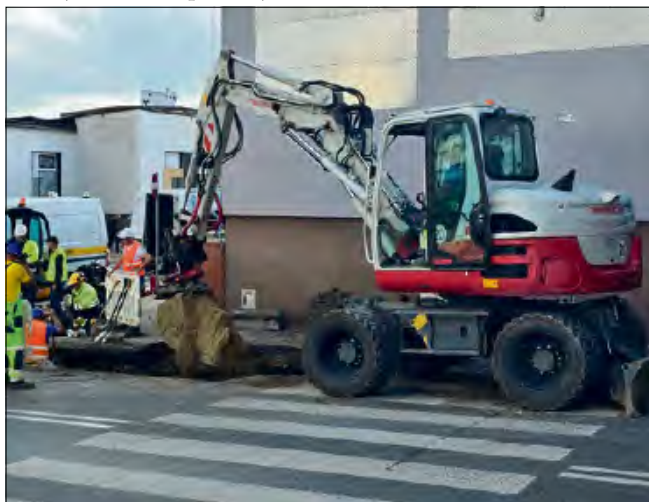
W wielu miejscach na terenie gminy Krapkowice trwają prace krapkowickiej spółki WiK związane z rozbudową i modernizacją infrastruktury wodno-kanalizacyjnej.
