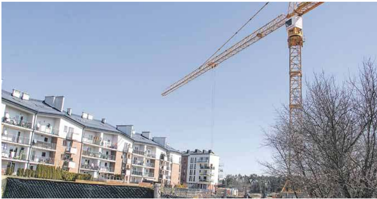
Ogrodzona działka Henryki Marciniak, na której stanął żuraw budowlany. Za płotem praca w re.
