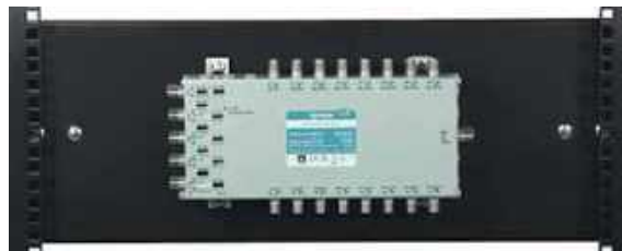
Montaż zespołu ZMB-1-800 do szyny rack w szafie
