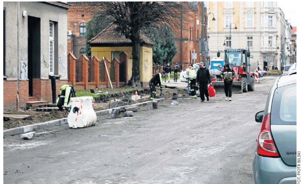
Na ulicy Mickiewicza jezdnię sfrezowano już na początku października
