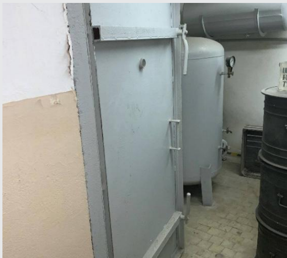
Fot. 3 Przykład istniejących stalowych drzwi ochronnych
