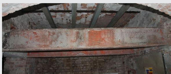
Fot. 5 Belki stalowe stropowe w pomieszczeniu schronu z lat 50. XX w. – wzmocnienie zostało rozebrane z uwagi na konieczność zabezpieczenia stropu międzykondygnacyjnego
