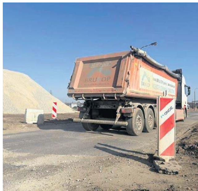
Ulica Podmiejska w czasie remontu ma być przejezdna, choć będą utrudnienia
