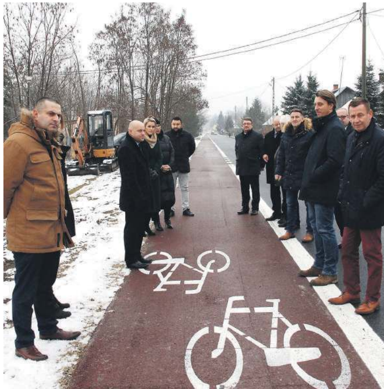
W ramach przebudowy wzdłuż odcinka drogi w Łazorach powstała ścieżka rowerowa
