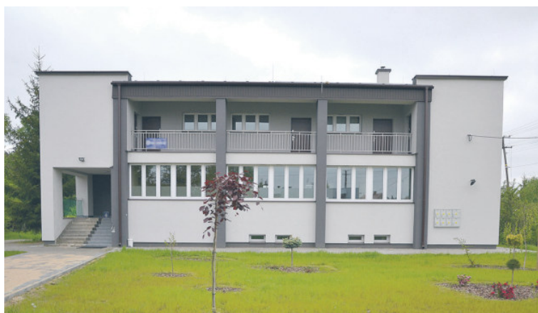
Budynek przychodni przy ul. Szkolnej
