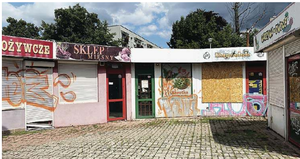
Część pawilonów została przeznaczona do rozbiórki. Elbląski ratusz przekazuje, że pomimo iż miasteczko handlowe działa tu już od 27 lat, to zagospodarowanie terenu związane z funkcją handlową należy traktować jako tymczasowe
