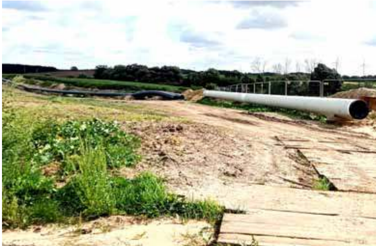
Fragment budowy gazociągu pomiędzy Steklnem i Babinkiem
