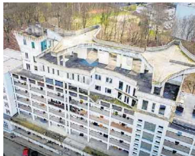
Część nadbudowy została już rozebrana
