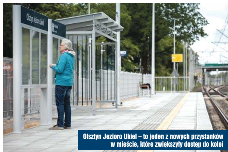
Stacja Pisz po modernizacji spełnia oczekiwany komfort podróży koleją
